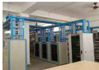
खरसिया यार्ड, रायपुर मंडल, द.पू.म.रे. में क्योसन निर्मित इलेक्ट्रॉनिक इंटरलॉकिंग
