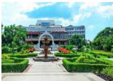
पूर्व मध्य रेलवे का मुख्यालय भवन रेल निकेतन
