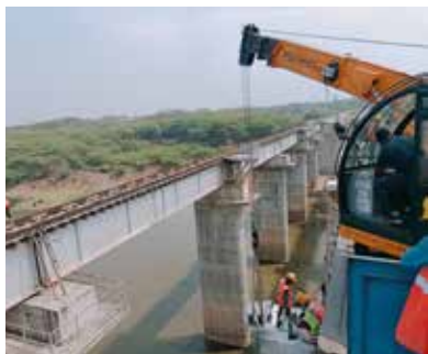
तोलाहुंसे-हुबली खंड में विद्युतीकरण के भाग के रूप में तुंगभद्रा पुल पर ओएचई मस्तूलों का निर्माण
