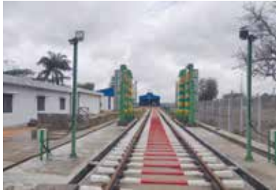
लमडिंग, असम में डेम्प/मेम्पू शेड का निर्माण
