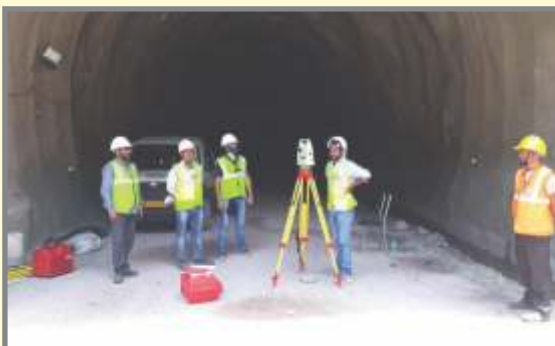
सुरंग निर्माण कार्य
