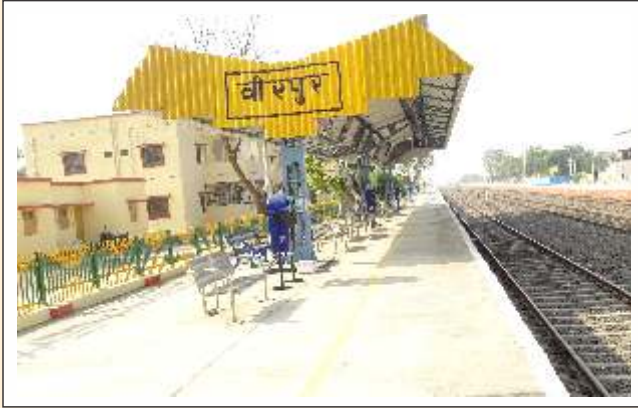
286 कवरशेड्स का निर्माण
