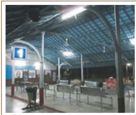
मकरपुरा स्टेशन पर LED लाइटें लगाई गईं
