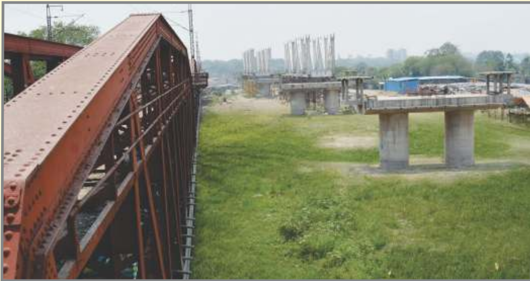
लोहे के पुल के अलावा यमुना के ऊपर नया ब्रिज निर्मित किया जा रहा है
