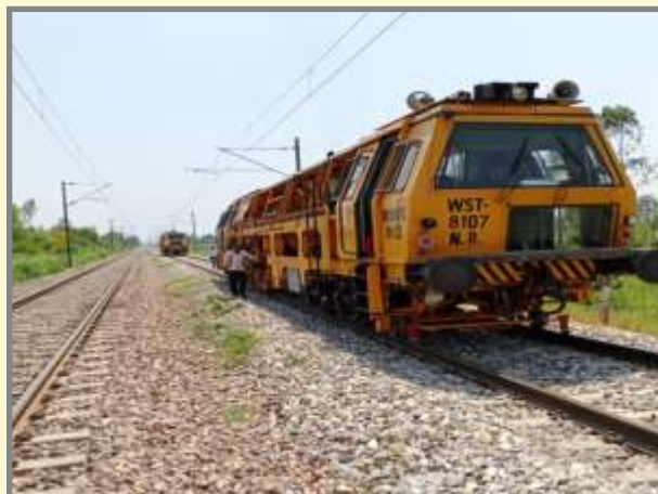
पटरियों के नवीनीकरण के लिए अत्याधुनिक UNIMAT एवं टैपिंग मशीनों का उपयोग
