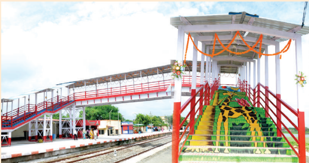
मधुबनी स्टेशन पर निर्मित पैदल उपरि पुल
